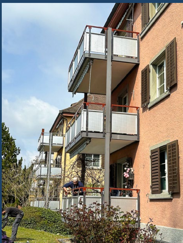
Die neuen Handläufe setzen einen Farbakzent
