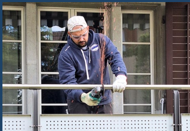
Demontage der alten Geländer
