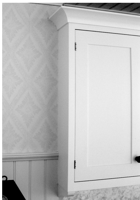
Sivulevy asennettuna seinäkaapin sivuun.
