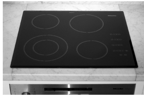
Kivitasoon tehty keittotason aukko. Huomaa etu- ja takaosan sekä ympäröivän työtason väliset liitokset.
