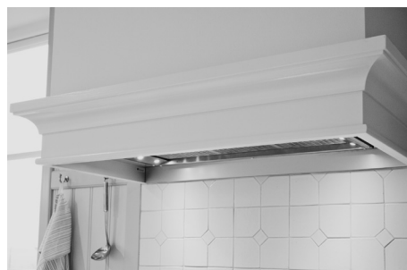
Sundby-liesituuletin, liesituulettimen yläosa on tasoitettu ja maalattu paikan päällä.
