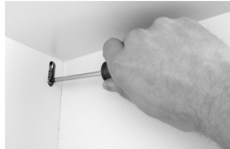
Kiinnikkeiden säätö on helppoa tasakärkisellä ruuvimeisselillä. Peitä reikä säätämisen jälkeen.
