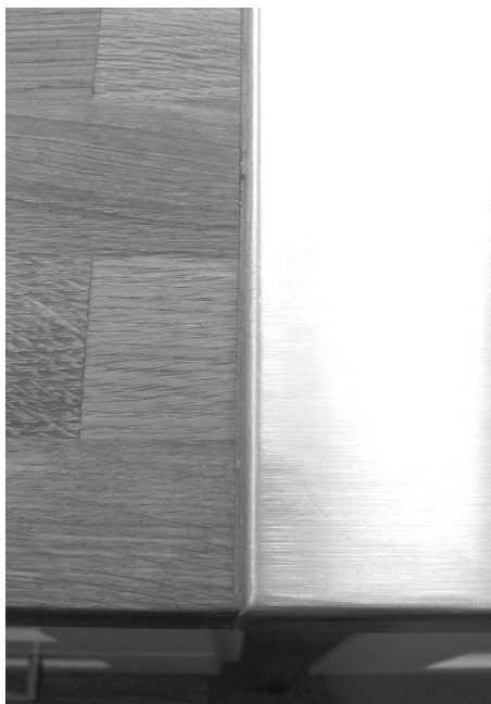
Fog mellan träbänkskiva och mötande rostfri diskbänk.
