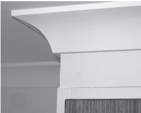
Takanslutning monterad mellan överskåp och taklist. Notera att takanslutningen är indragen ett par mm i förhållande till överskåpet.
