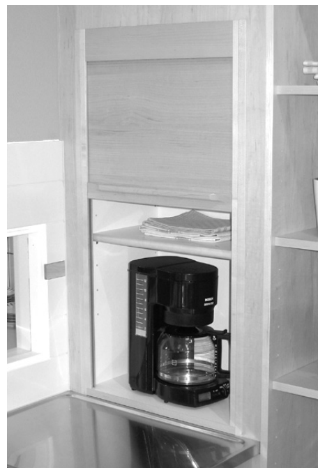
Jalusiskåp med delvis öppen lucka. Var noga vid monteringen så att sidorna på skåpet ej pressas samman. Jalusiluckan kan då bli trög att manövrera.
