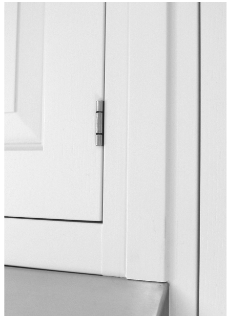
Liesituulettimen viereen asennettu suora pilasteri.
