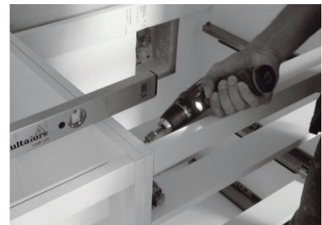
Ruuvien kiinnitys mahdollisimman lähelle yksikön ylä- ja alareunaa.
