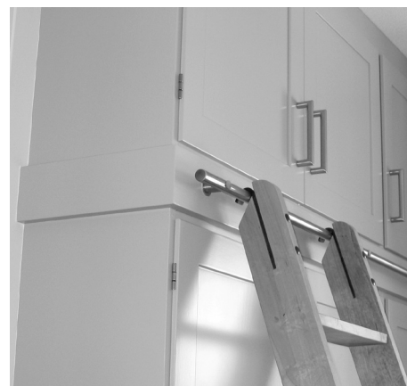
Kiskoon nojaavat tikkaat. Huomaa, että kisko on kiinnitetty yksiköiden väliseen välikappaleeseen.
