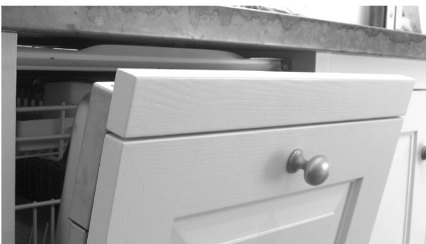
Yksityiskohta laitteesta, johon on asennettu kalusteovi.
