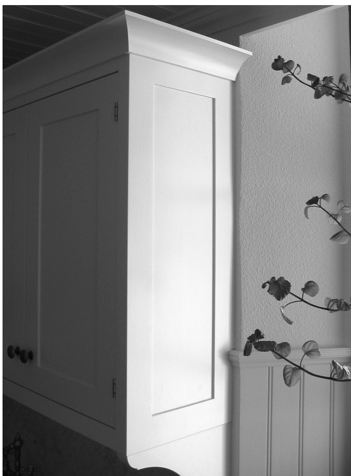
Päätykasetti , joka on asennettu seinäkaapin sivuun.
