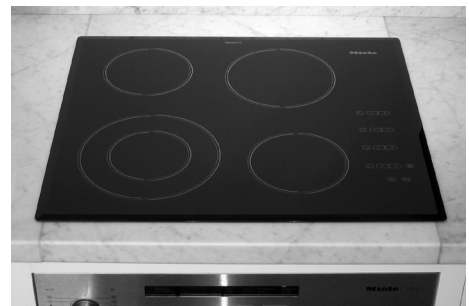
Delat urtag vid en häll monterad i en stenskiva. Notera skarvarna mellan den främre och bakre listen och omgivande skivor. Alla skivor ska i bakkant och sidor fogas så att inte fukt släpps igenom.
