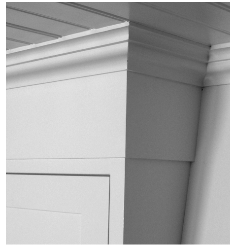
Takanslutning monterad mot regel i taket och mot övre delen av skåpet.
