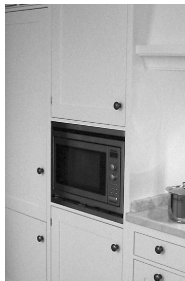
Högskåp för inbyggnad av ugn eller micro. Notera att microns front ligger helt i liv med stommens framkant.
