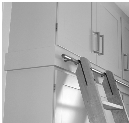
Stegen vilande mot reling. Notera att relingen fästs i en distansregel mellan skåpen.
