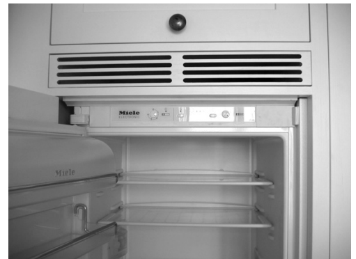
Helintegrerad kyl monterad i högskåp. Notera anslagslisten.
