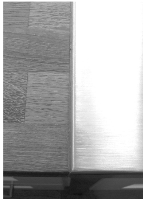
Fog mellan träbänkskiva och mötande rostfri diskbänk.
