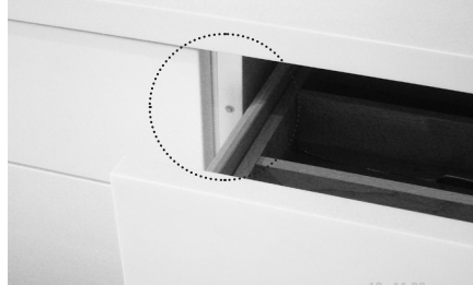
Tappi asennettuna laatikkoon. Vierekkäisissä ovissa käytetään jousitappeja, jotta ovet ovat samalla etäisyydellä yksikön rungosta.
