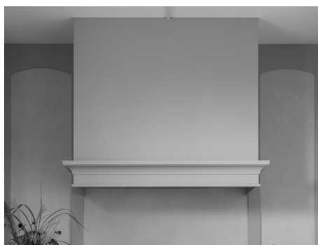
Sundby-liesikuvun yläosa tasoitetaan ja maalataan paikan päällä.
