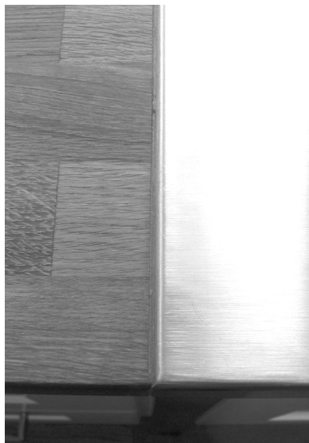
Tiivistä puutason ja ruostumattomasta teräksestä valmistetun altaan välinen sauma.
