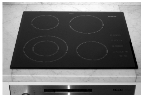
Kivitasoon asennetulle keittotasolle tehty aukko. Huomioi etu- ja takakaistaleiden sekä ympäröivien työtasojen väliset liitokset. Kaikki työtasot on tiivistettävä takaa ja sivuilta, jotta kosteus ei pääse tunkeutumaan kalusteisiin.
