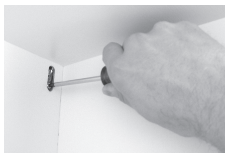
Ripustuskiinnikettä voidaan säätää helposti tavallisella ruuvimeisselillä. Peitä tämä reikä suojakannella säädön jälkeen.
