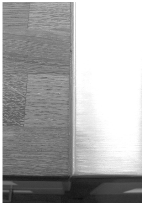
Tiivistä puutasot ja ruostumattomasta teräksestä valmistetun altaan välinen sauma.
