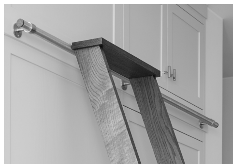
Kiskoa vasten nojaavat tikkaat. Huomaa, että kisko on kiinnitetty yksiköiden väliin kiskon kannakkeisiin, jotta tikkaiden ja yksiköiden väliin jää tarpeeksi tilaa eivätkä tikkaat kosketa yksiköitä.
