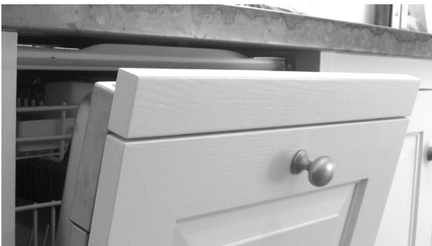
Yksityiskohta ovesta, johon on asennettu peitelevy.
