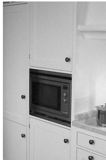
Korkea yksikkö integroitavalle uunille tai mikrolle. Huomaa, että mikron etuosa on samassa tasossa rungon etureunojen kanssa.
