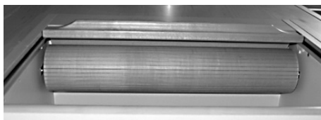
Täysin auki oleva yksikkö, jonka rullaovi on kierretty yksikön yläosan alle. Kuvattu alhaalta päin.
