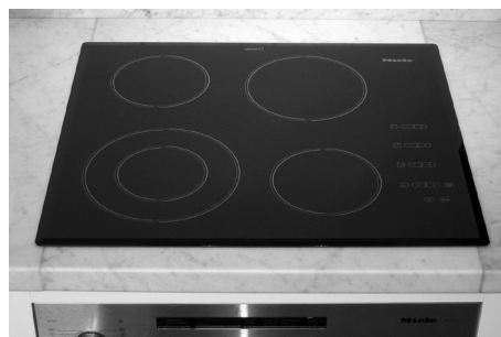
Delat urtag vid en häll monterad i en stenskiva. Notera skarvarna mellan den främre och bakre listen och omgivande skivor. Alla skivor ska i bakkant och sidor fogas så att inte fukt släpps igenom.
