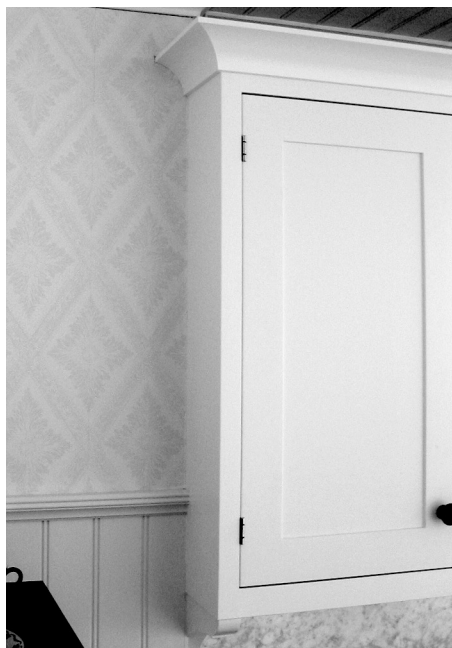
Täcksida monterad på sidan av ett överskåp.
