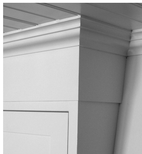
Takanslutning monterad mot regel i taket och mot övre delen av skåpet.
