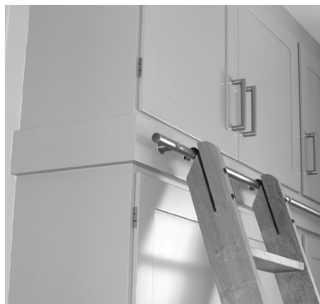
Stega vilande mot reling. Notera att relingen fästs i en distansregel mellan skåpen.
