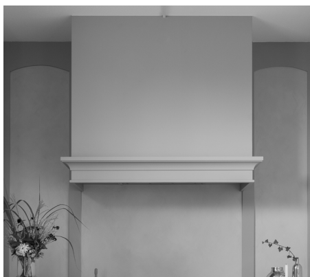
Fläktkåpan Sundbys överdel spacklas och målas på plats.
