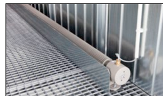
Convecteur électrique avec protection anti-choc
