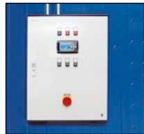
Armoire électrique pour un raccordement central
