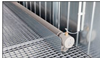
Convecteur à ailettes avec limiteur de température intégré et barres de renfort
