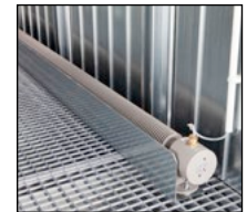
Convecteur électrique avec protection anti-choc
