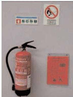
De acordo com o RTSCIE, os extintores não devem estar obstruídos nem ocultos, devem estar devidamente sinalizados e devem ser colocados em suporte próprio de modo a que o seu manípulo fique a uma altura não superior a 1,2 m do pavimento e localizados preferencialmente:
