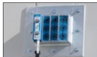
**Brandschutz-Schottsystem für Kabel- / Rohrdurchführungen**
