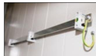
**Erdungsschiene im Inneren des Raumsystems**
