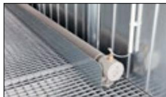
**Rippenrohrheizung mit integriertem Sicherheitstemperaturbegrenzer und Rammschutzblech**
