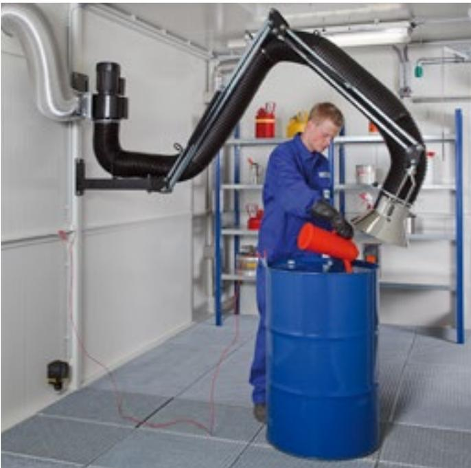
**Umfüllraum mit integriertem Absaugarm für die punktuelle Absaugung gesundheitsgefährdender Dämpfe**
