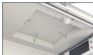
**Druckentlastungsfläche im Dachbereich**
