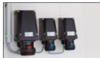
**Steckdosen zum Anschluss weiterer Arbeitsgeräte (230 V oder 400 V, 50 Hz.)**
