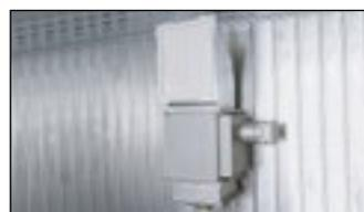
**Heizlüfter für eine aktive und gezielte Konvektion in größeren begehbaren Gefahrstofflagern**
