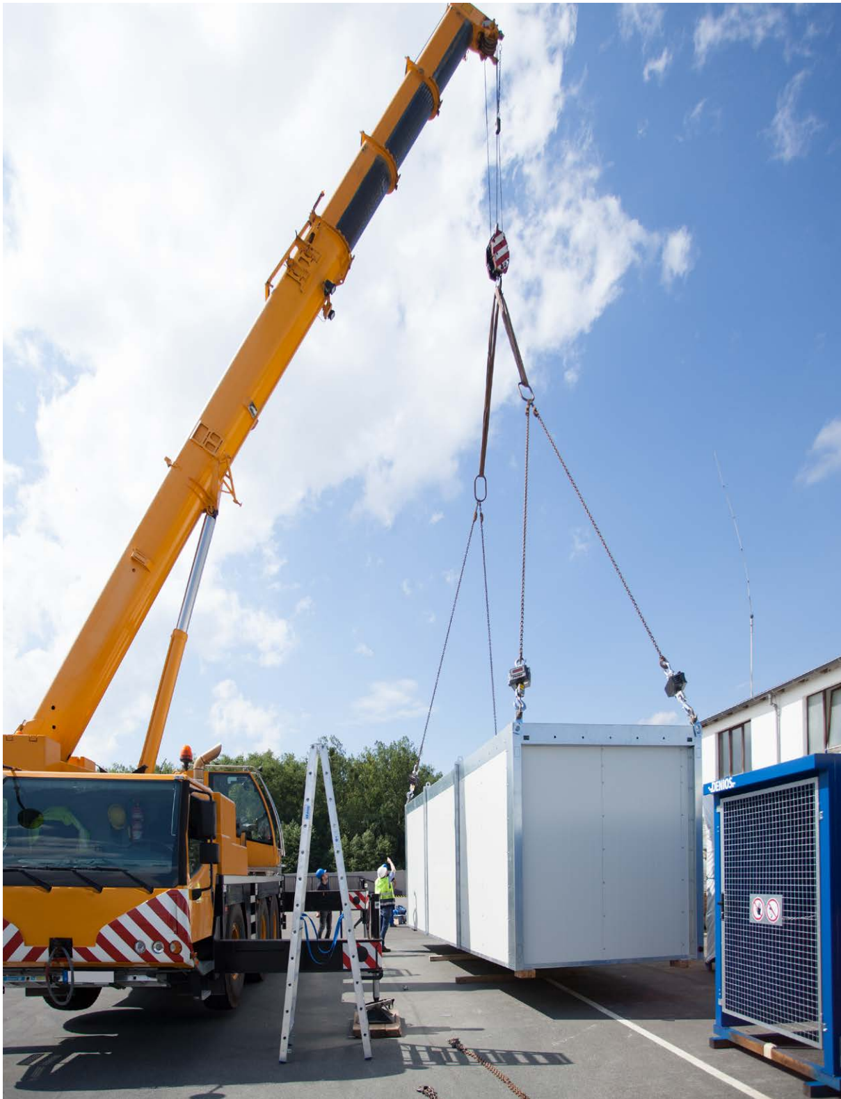
Une grue est généralement utilisée pour mettre en place un conteneur ou un bungalow à l'extérieur.
