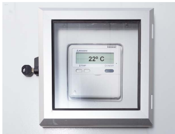
Affichage de la température pour un conteneur ou bungalow de stockage climatisé.
