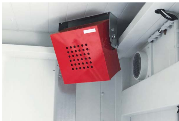
Le système d'extinction par aérosol est déclenché par la température et interrompt efficacement le processus de combustion chimique en 4,5 à 15 secondes, selon le modèle.
