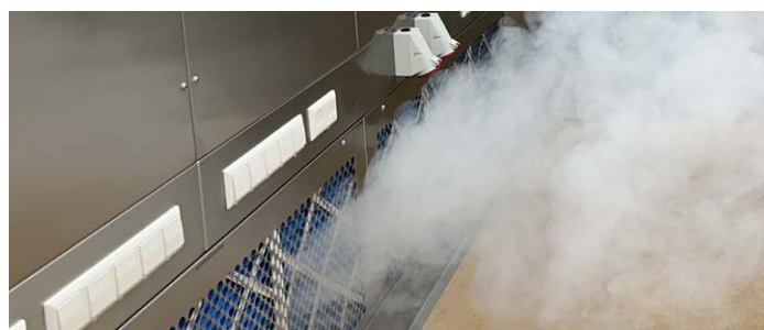
Afb. 8: Deeltjes in de lucht worden effectief opgevangen doordat ze naar de vloer geduwd en afgezogen worden.
