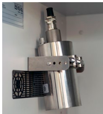
Elektroniczny system tłumienia pożaru
