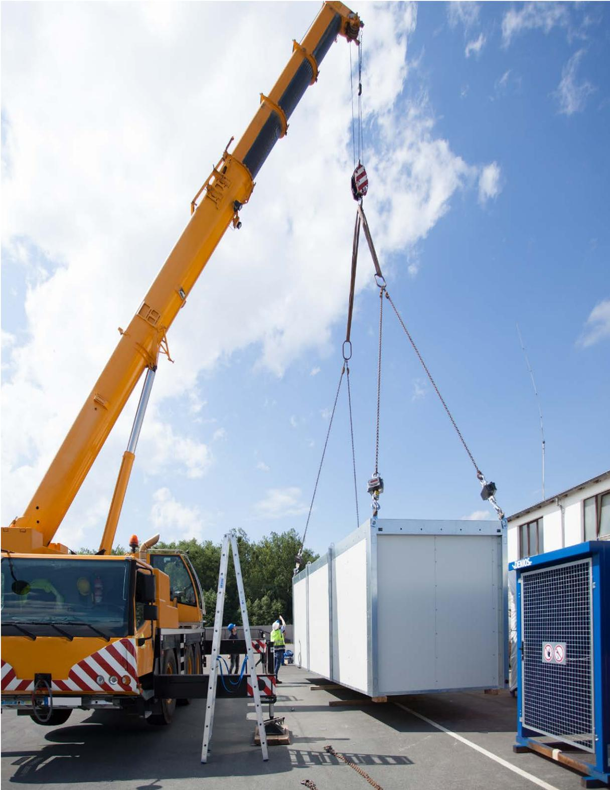
Für die Aufstellung eines Gefahrstofflagers im Aussenbereich kommt in der Regel ein Kran zum Einsatz.
