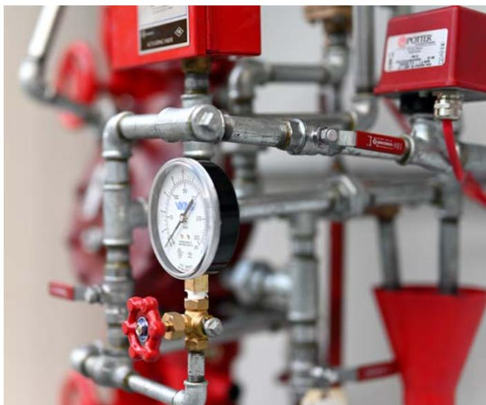
Impianto di spegnimento incendi - sprinkler con valvola diluvio connesso a centralina.
