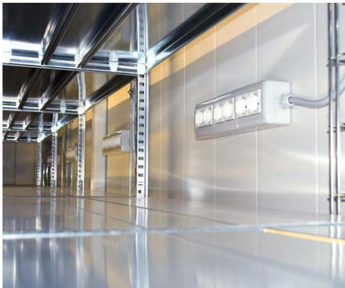
I sistemi di scaffature integrati permettono uno stoccaggio ordinato delle batterie, anche nei depositi accessibili al personale. E' inoltre possibile dotare i depositi di prese elettriche per la carica degli accumulatori.
