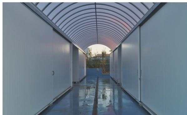
La coibentazione dei depositi è stata realizzata con pannelli sandwich da 50 mm in lana di roccia. La resistenza a carico neve è di 250 kg/m<sup>2</sup> e quella al vento è di 58 kg/m<sup>2</sup>.
