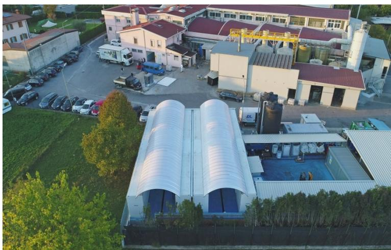
La richiesta a DENIOS è stata quella di creare un'area di stoccaggio coperta, con una superficie totale di circa 300 m<sup>2</sup>, che contemporaneamente garantisse sicurezza nello stoccaggio delle differenti tipologie di liquidi, permettesse di razionalizzare i flussi produttivi ed ottimizzasse i tempi di percorrenza dai depositi di stoccaggio alla zona di produzione e trattamento.
