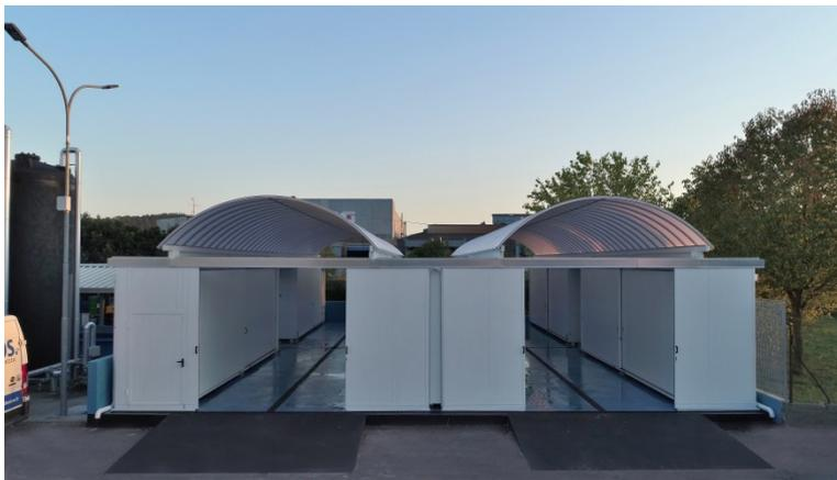
Le otto unità sono state disposte a formare due corridoi di 18,5 metri di lunghezza e 3,7 metri di larghezza, per una superficie complessiva di circa 300 m<sup>2</sup>.
