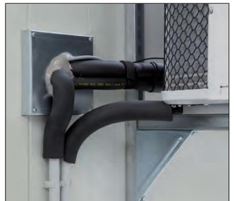
Brandgeschützte Durchführung von Rohren in einer Seitenwand
