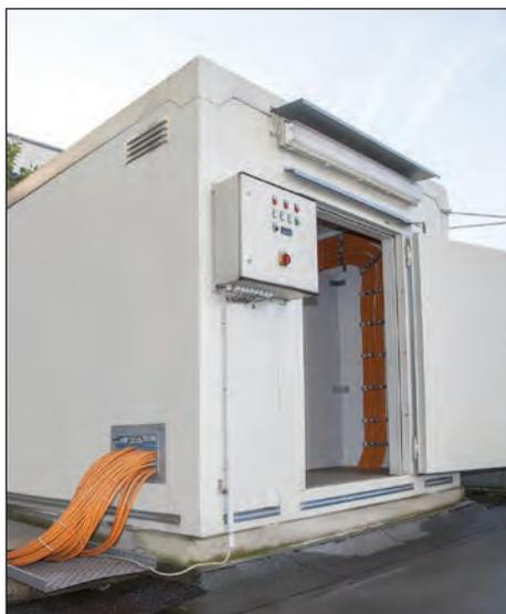
F90-Brandschutzcontainer, Kabeleinführung in den Doppelboden
