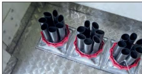
➔ Abbildung links: Bodendurchführungen mit Brand- und Nagetierschutz, gas- und wasserdicht
