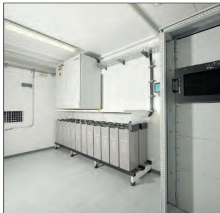
Blick in den Technikraum mit Brennstoffzellen und entsprechenden Speichermedien
