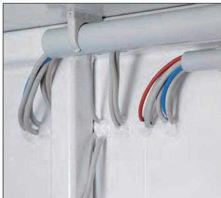
Brandgeschützte Durchführung von Kabeln in einer Seitenwand
