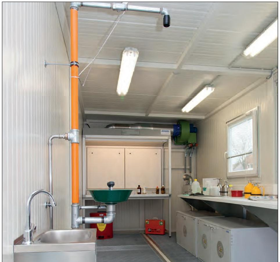
Probenahme- / Analyseraum mit Lufttechnik-Arbeitsplatz und Notdusche. Zusätzliche Sicherheit bieten die brandgeschützten Unterbauschränke für Rückstellproben.
