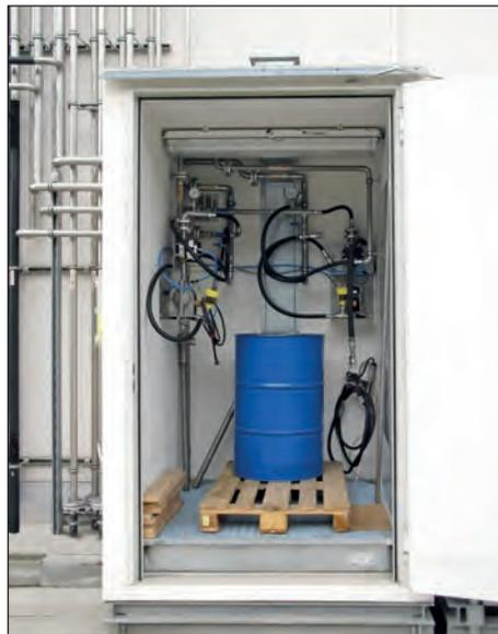
Benzindosierung für Motorenprüfstände – Innenansicht
