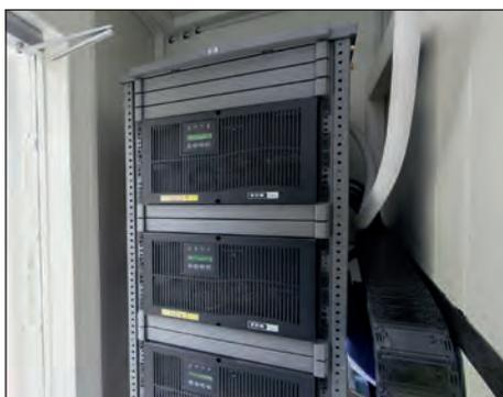
Die USV wurde räumlich von der IT-Technik separiert – in einem zweiten Brandabschnitt
