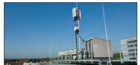
Funkzentrale mit Technik- / Sicherheitsraum auf dem Flachdach eines Verwaltungsgebäudes
