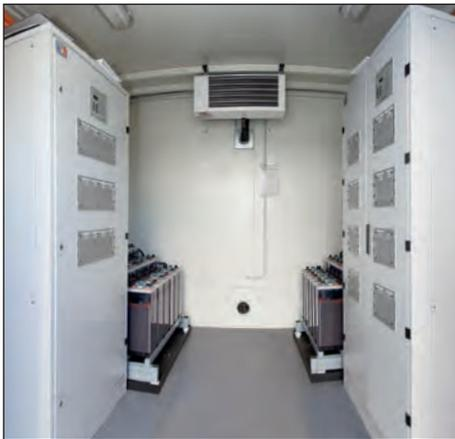
Blick auf die unterbrechungsfreie Stromversorgung (USV) im Container
