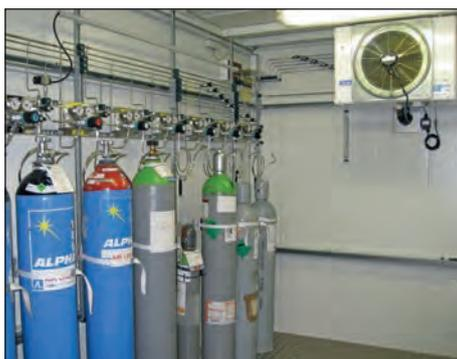
Unterbringung von technischen Gasen in einem klimatisierten Sicherheitsraum mit Brandschutz
