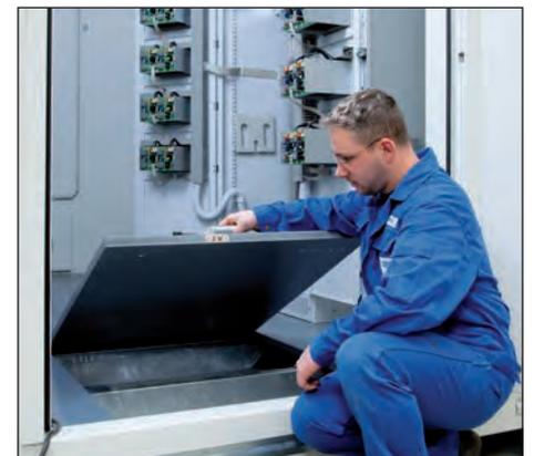
Doppelboden mit Revisionsklappe
