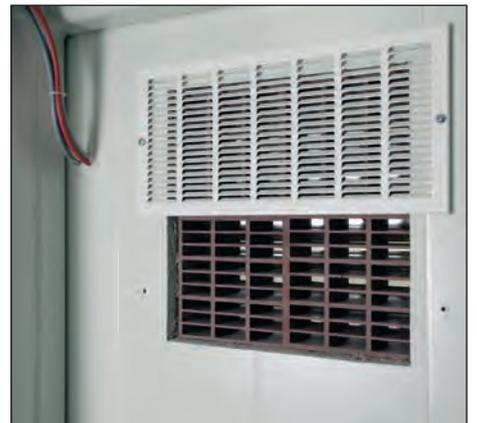
Lüftungsbaustein mit Schmelzsicherung
