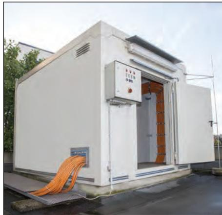
F90-Brandschutzcontainer, Kabeleinführung in den Doppelboden
