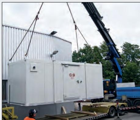
Abladen mittels Autokran auf das vorbereitete Fundament
