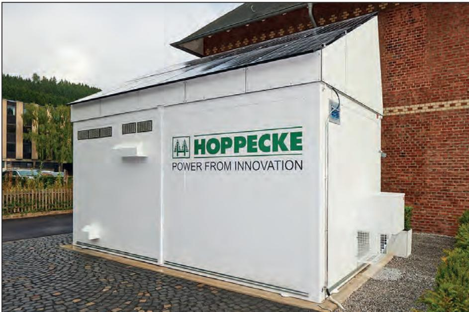
Neben den Brennstoffzellen kommt hier als Energieerzeuger eine auf dem Containerdach platzierte Photovoltaik-Anlage zum Einsatz.
