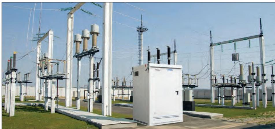
Umspannstation mit dezentralem Technik- / Sicherheitsraum
