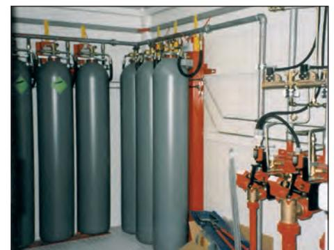
CO<sub>2</sub> Löschgasbatterie fertig angeschlossen
