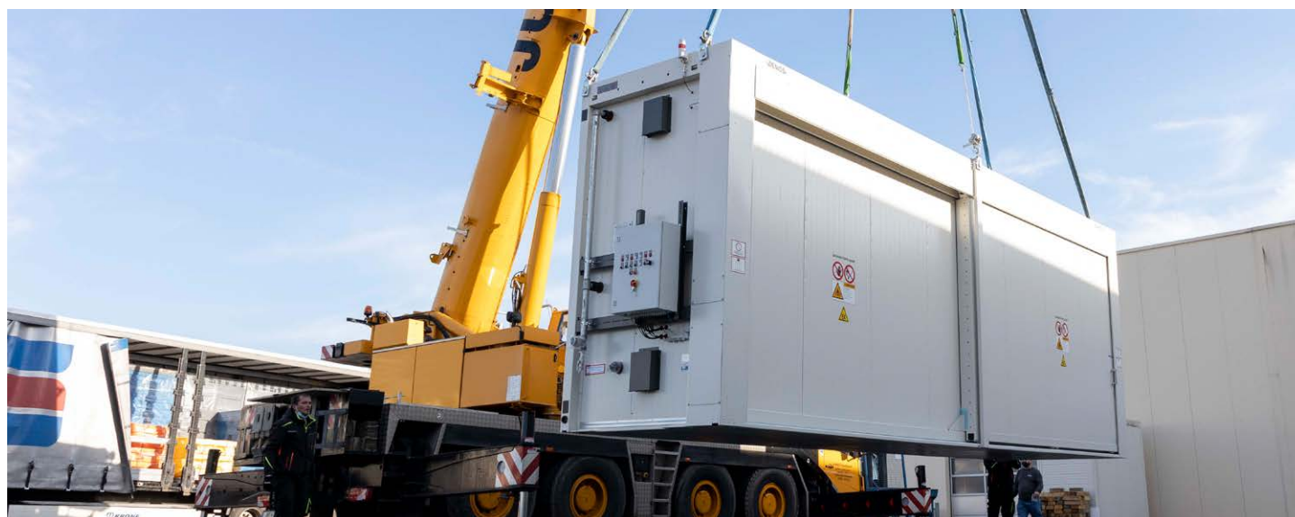
Afb. 6: Het stekkerklare systeem wordt geleverd met een dieplader en gelost met een vorkheftruck of kraan.
