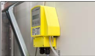
Abluftüberwachung
