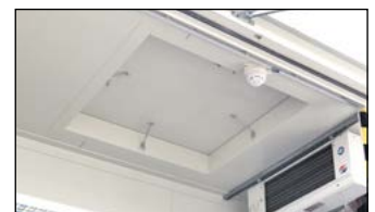
Druckentlastungsfläche
