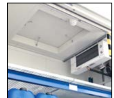
Druckentlastungsfläche
