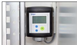
Systemüberwachung / Gaswarndetektor
