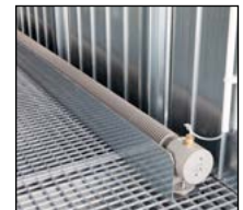
Rippenrohrheizung mit Anfahrerschutz
