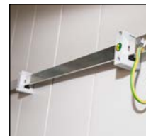
Erdungsschiene
