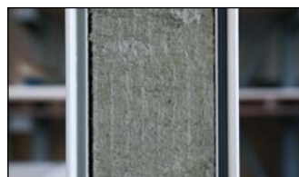
Brandschutzpaneel aus nicht brennbarem A-Material (Mineralwoll-Paneeel)
