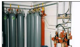
CO 2 Löschanlage
