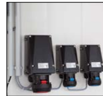
Steckdosen in Ex-Ausführung
