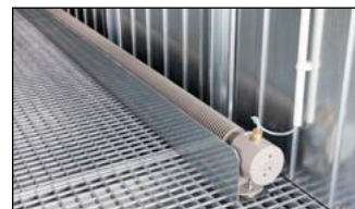
Rippenrohrheizung mit Anfahrerschutz
