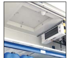
Druckentlastungsfläche
