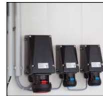
Steckdosen in Ex-Ausführung
