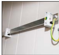
Erdungsschiene
