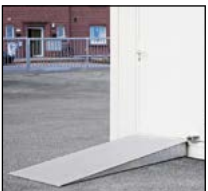
lange Rampe, hubwagenbefahrbar
