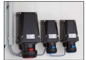
Steckdosen in Ex-Ausführung
