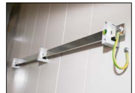
Erdungsschiene
