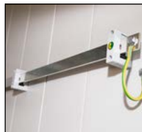
Erdungsschiene
