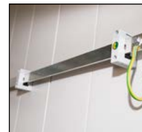
Erdungsschiene
