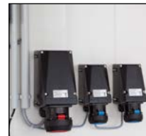
Steckdosen in Ex-Ausführung
