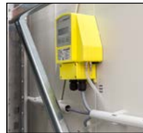
Abluftüberwachung bei Luftwechsel > 2,0/h
