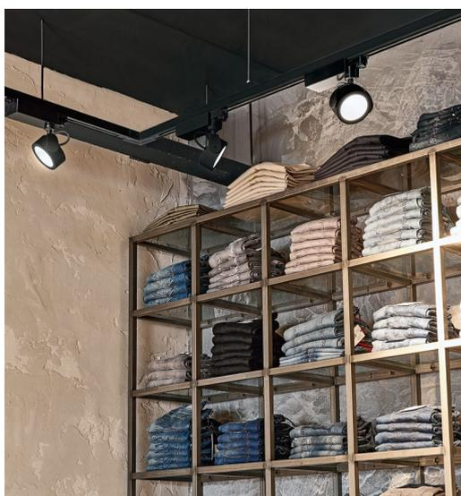
Les conducteurs triphasés d'un rail peuvent être placés indépendamment les uns des autres (par exemple, pour les projecteurs, panneaux et suspensions). Ces trois circuits peuvent être exploités individuellement, rendant possible l'éclairage de zones séparées d'un magasin (éclairage de base, éclairage de la caisse, accentuation des zones d'exposition). Dans les vitrines, des scènes différentes peuvent être mises en lumière de jour comme de nuit.
