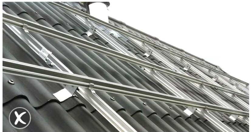
Pendant la mise en pose des panneaux solaires, il est strictement interdit de marcher directement sur les plaques ondulées et doit être prévu une marche de plancher assez stable. Des dommages sur les plaques ondulées après la mise en pose des panneaux solaires n'est pas en vertu de la garantie.
