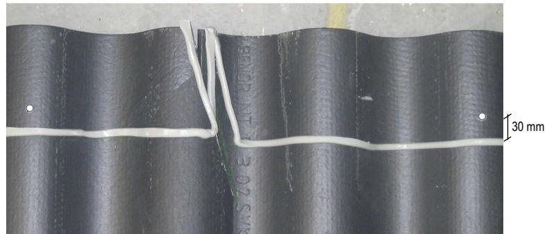
*Mastic entre les recouvrements longitudinal et transversal:*
