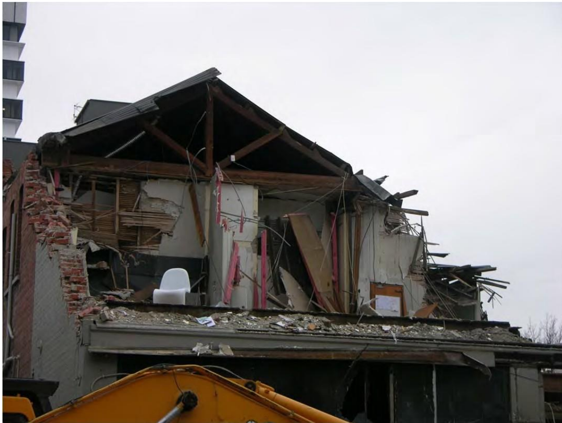
Illustration 7 : Dommages subis par une structure de maçonnerie non renforcée, Christchurch, Nouvelle-Zélande, 2010
