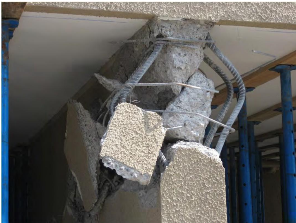
Illustration 6 : Dommages à une structure de béton armé causés par les secousses, Chili 2010
