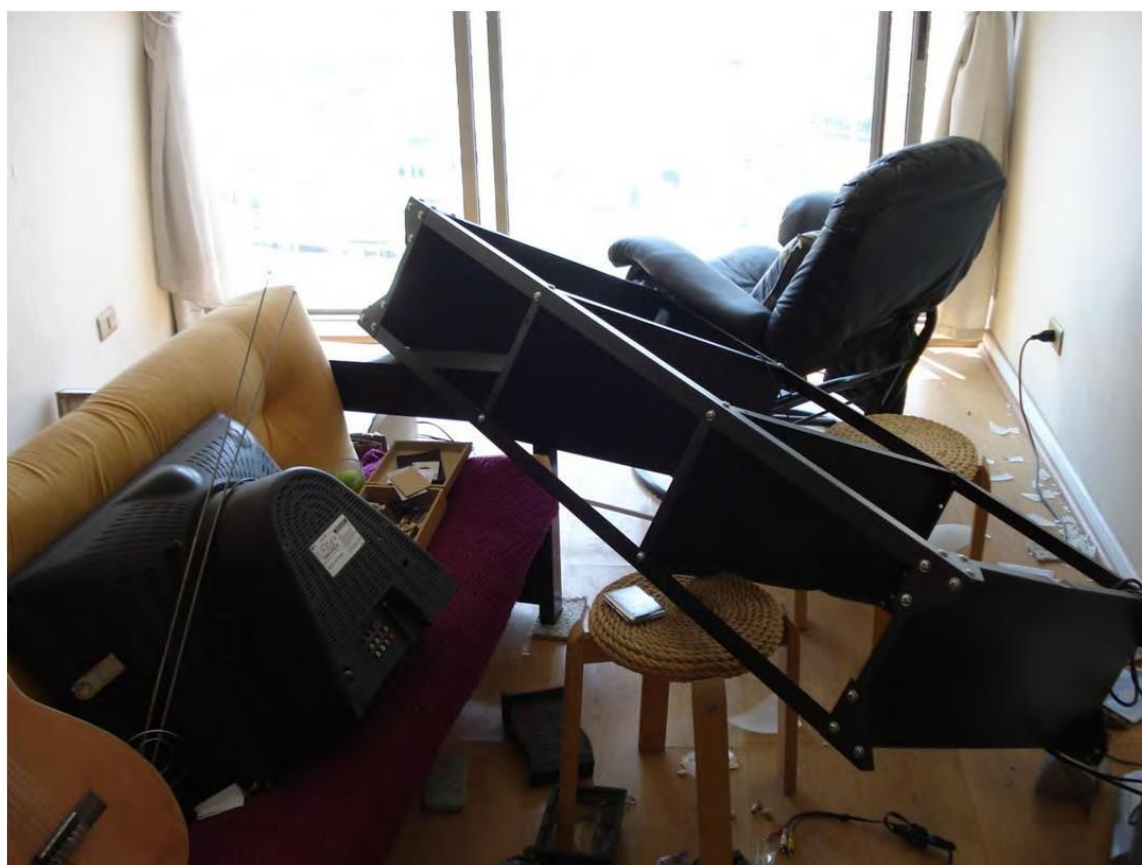
Illustration 19 : Chute d'armoire et d'accessoires fixes représentant des dommages à une habitation d'intensité VI à l'échelle de MM, au Chili en 2010.
