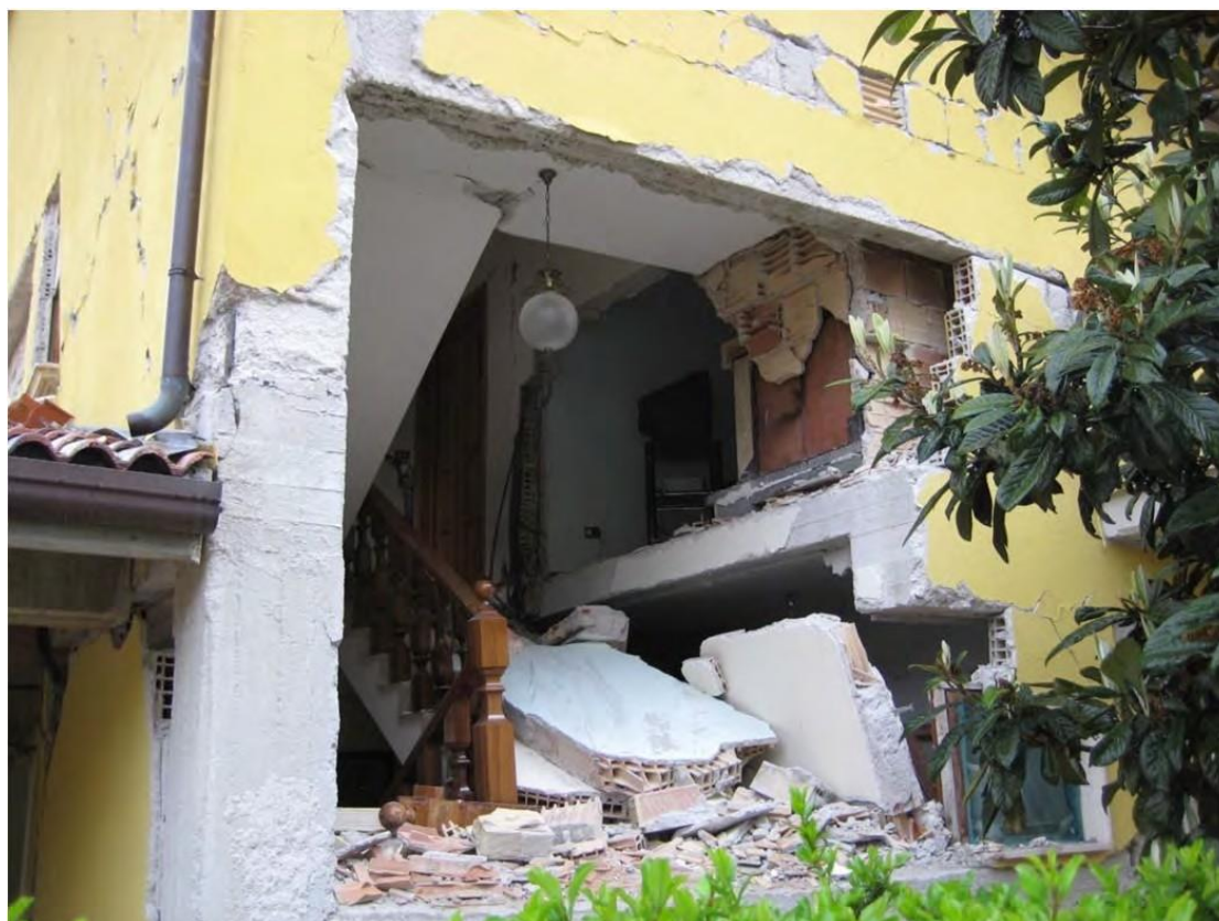
Illustration 23 : Dommages à une structure résidentielle à L'Aquila, en Italie, en 2009
