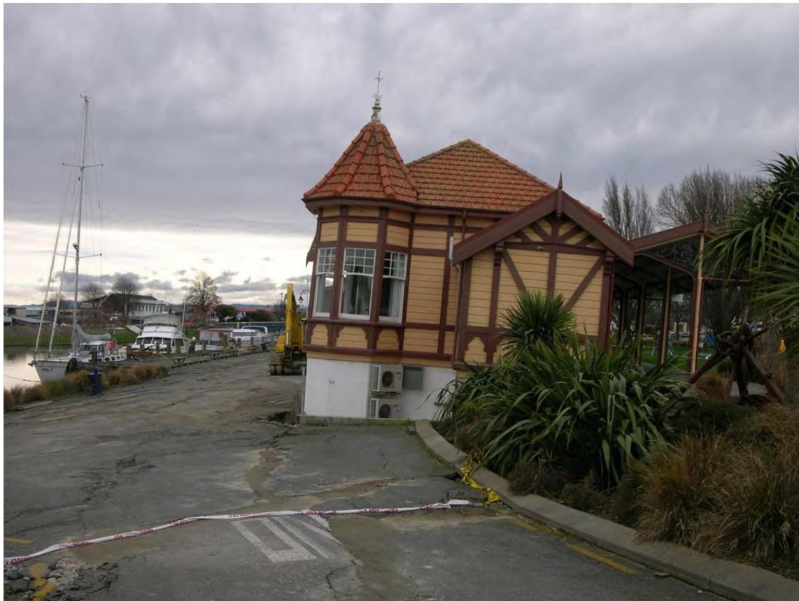
Illustration 8 : Signe de liquéfaction lors du tremblement de terre de 2010 à Christchurch en Nouvelle-Zélande
