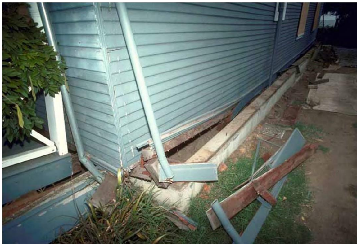
Illustration 74 : Dommage par séisme lorsqu'une maison n'est pas fixée à sa fondation (J.K. Nakata, U.S. Geological Survey)
