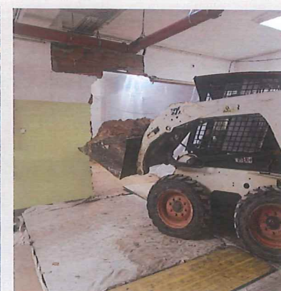
Escavação da despensa
