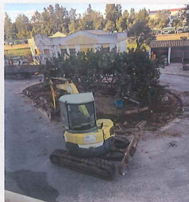
Alargamento de acessos
