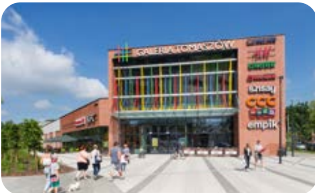
Galeria Tomaszow Tomaszow Mazowiecki
