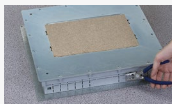
1. Recortar las entradas de canal
