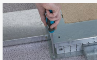
2. Introducir las canales y atornillar al suelo
