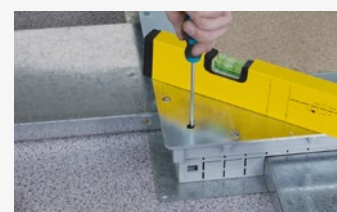
3. Nivelar con los tornillos
