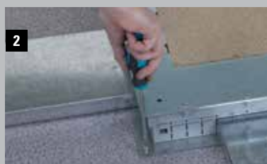
2 Insérer les goulottes et visser au sol
