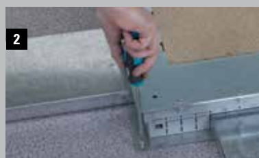
2 Insérer les goulottes et visser au sol
