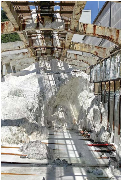
Die Sanierung des Salzlagers ist nur eines von vielen Modernisierungsprojekten in Brückl.
