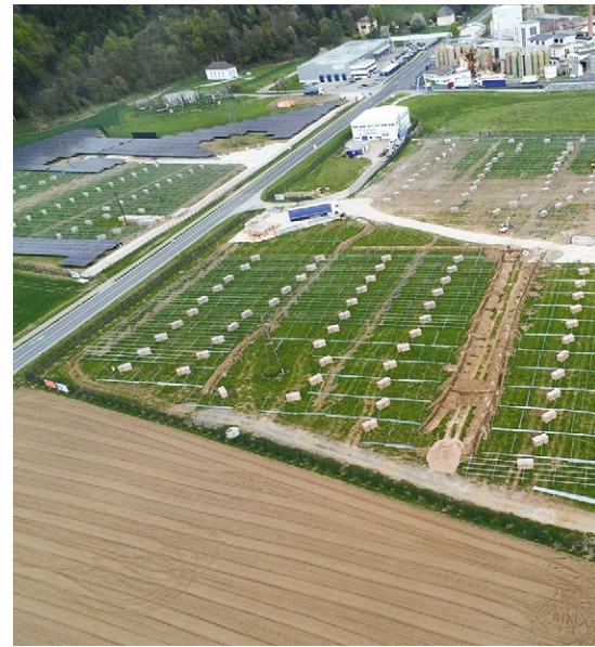
Oben links: Die neue Freiflächen-PV-Anlage liegt direkt neben dem Werk. Oben rechts: Insgesamt werden 16.000 Solarmodule verbaut.
