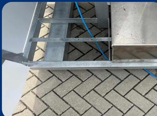
7. Ziehen Sie das Kabel mit dem CEE-Stecker durch die Unterseite des Rahmens, damit es nicht zwischen der Tür eingeklemmt wird.
