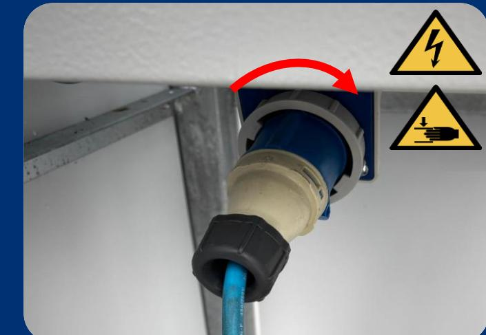
8. Schließen Sie den CEE-Stecker an den Systemschrank an und verriegeln Sie ihn durch Drehen des Sicherungsrings.
