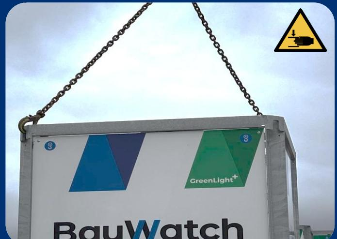
3. Verwenden Sie eine zugelassene Hebekette (mindestens 2-strängig) quer, um den Turm anzuheben. Verwenden Sie die Hebeösen.
