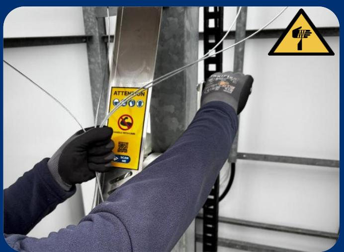
5. Sujete los cables de sujeción sin apretarlos y guíelos mientras eleva el mástil. Asegúrese de que los cables de sujeción no se enganchen en nada.
