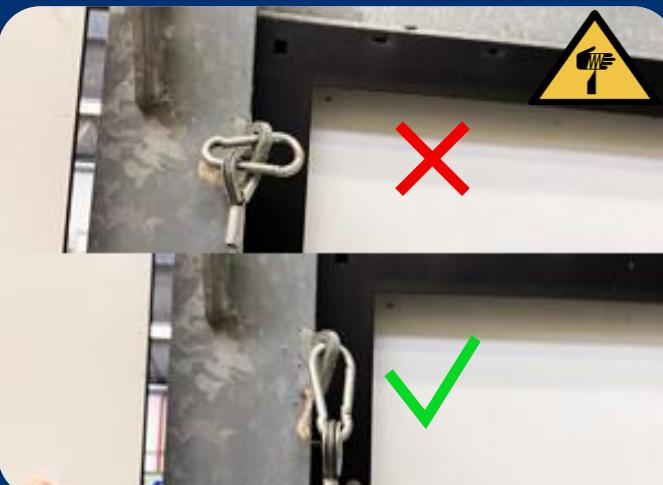
4. Antes de elevar el mástil, compruebe que los ganchos de los cables de sujeción se pueden mover libremente en el orificio.
