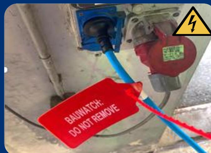
8. Conecte el cable alargador (cable a través de la parte inferior del bastidor) y déjelo en la caja de la batería. Coloque los cables en la entrada y cierre la tapa.
