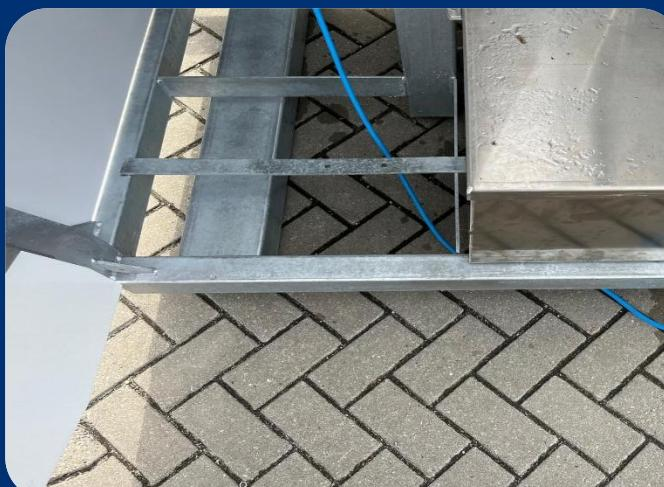
7. Tire del cable con el enchufe CEE a través de la parte inferior del marco para que no quede atrapado entre la puerta.
