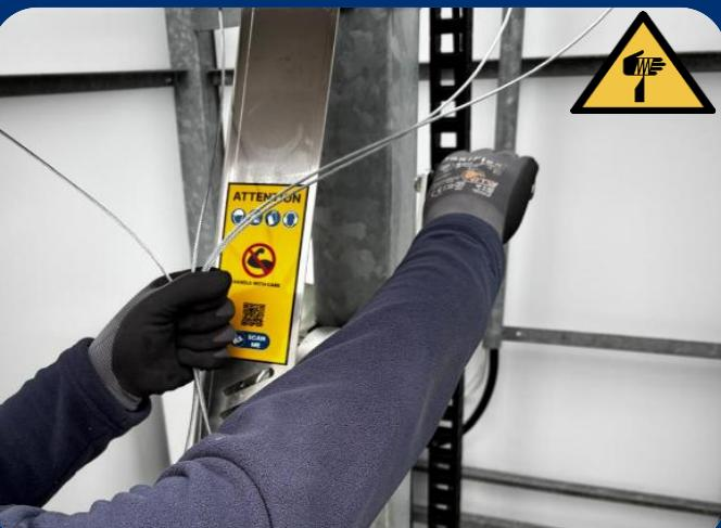
4. Sujete los cables de sujeción sin apretarlos y guíelos mientras eleva el mástil. Asegúrese de que los cables de sujeción no se enganchen en nada.
