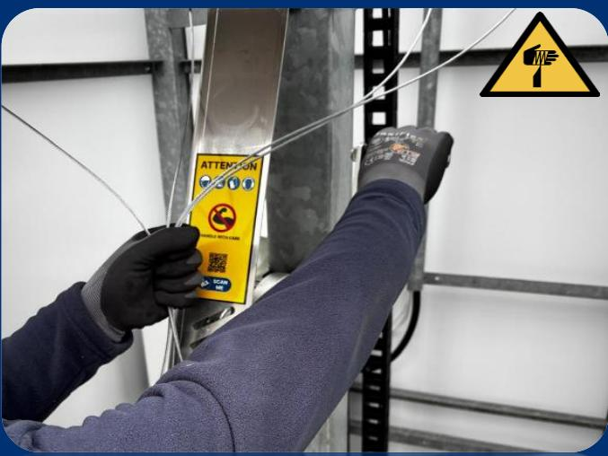
5. Halten Sie die Abspinnseile locker und führen Sie sie beim Anheben des Mastes. Achten Sie darauf, dass sich die Abspinnseile nirgendwo verfangen.
