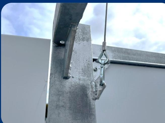
6. Prima che l'albero sia completamente esteso, controllare nuovamente i ganci per assicurarsi che siano ancora fissati saldamente.
