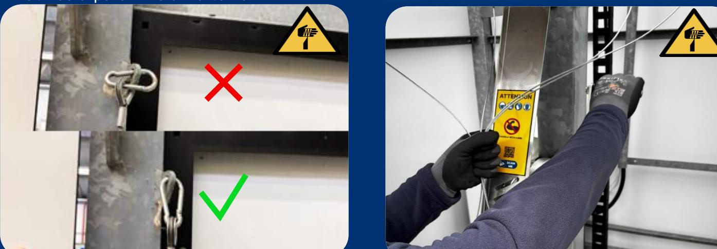
6. Sujete los cables de sujeción sin apretarlos y guíelos mientras eleva el mástil. Asegúrese de que los cables de sujeción no se enganchen en nada.
