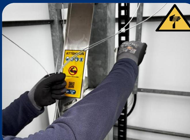
6. Halten Sie die Abspannseile locker und führen Sie sie beim Anheben des Mastes. Achten Sie darauf, dass sich die Abspannseile nirgendwo verfangen.
