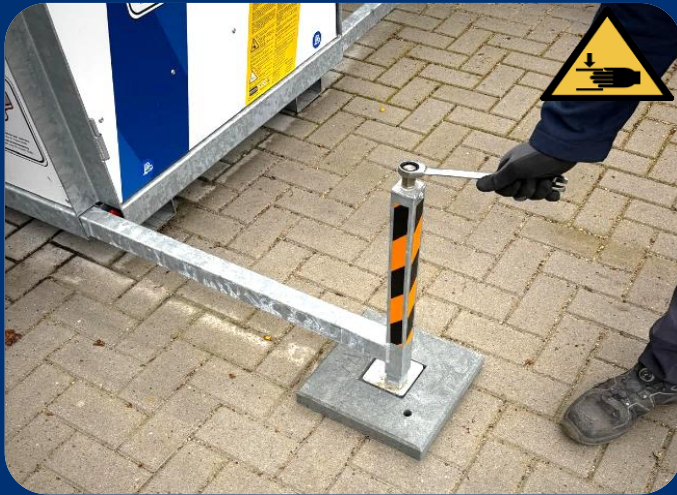
3. Tirez les pieds de support vers l'extérieur et placez une tuile en dessous. Utilisez la clé de 19 mm pour dévisser les pieds. Utilisez-la pour mettre la tour à niveau.
