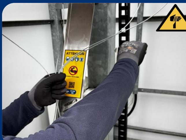
6. Halten Sie die Abspinnseile locker und führen Sie sie beim Anheben des Mastes. Achten Sie darauf, dass sich die Abspinnseile nirgendwo verfangen.
