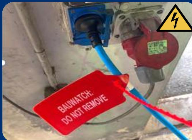
8. Conecte el enchufe CEE al armario del sistema y bloquéelo girando el anillo de retención.
