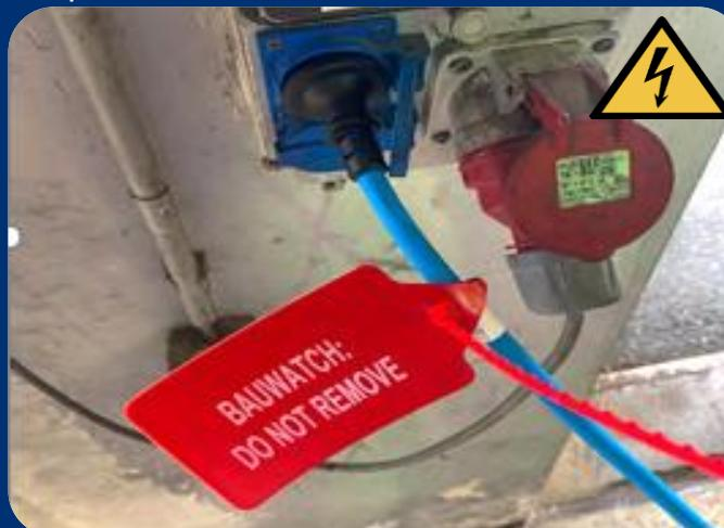
8. Collegare la spina CEE all'armadio di sistema e bloccarla ruotando l'anello di fissaggio.
