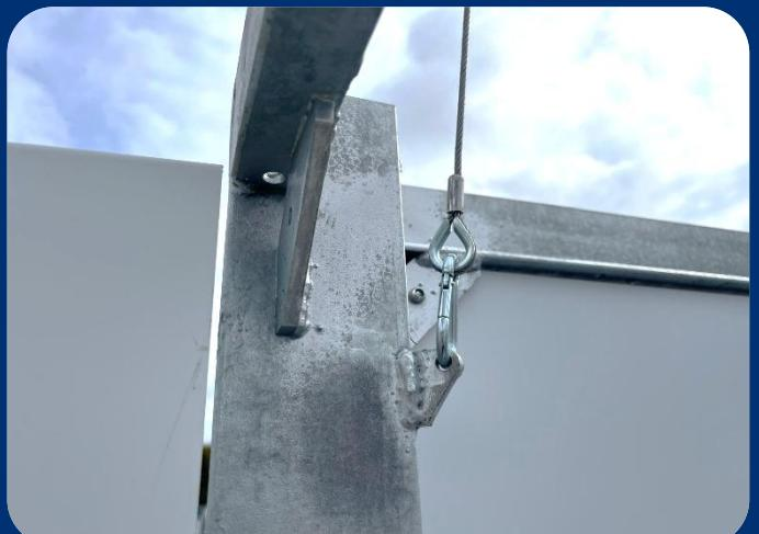
5. Prima che l'albero sia completamente esteso, controllare nuovamente i ganci per assicurarsi che siano ancora fissati saldamente.
