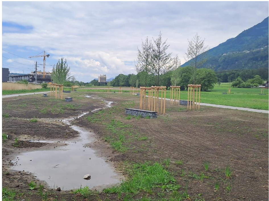
Foto nach der Fertigstellung
