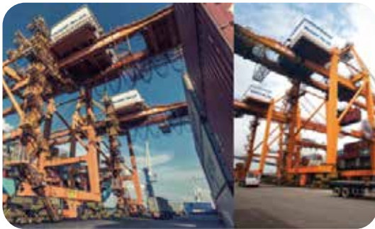
ก.) เครนยกตู้คอนเทนเนอร์บริเวณหน้าท่า แบบเลื่อนแนวตรง (Gantry Crane)
