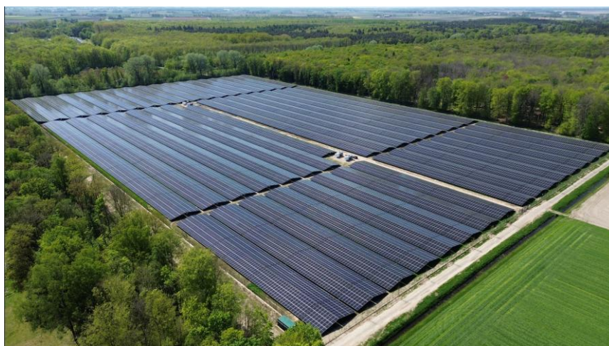
Die Anlage in Marknesse mit einer Ost-West-Ausrichtung der Module, © CCE.
