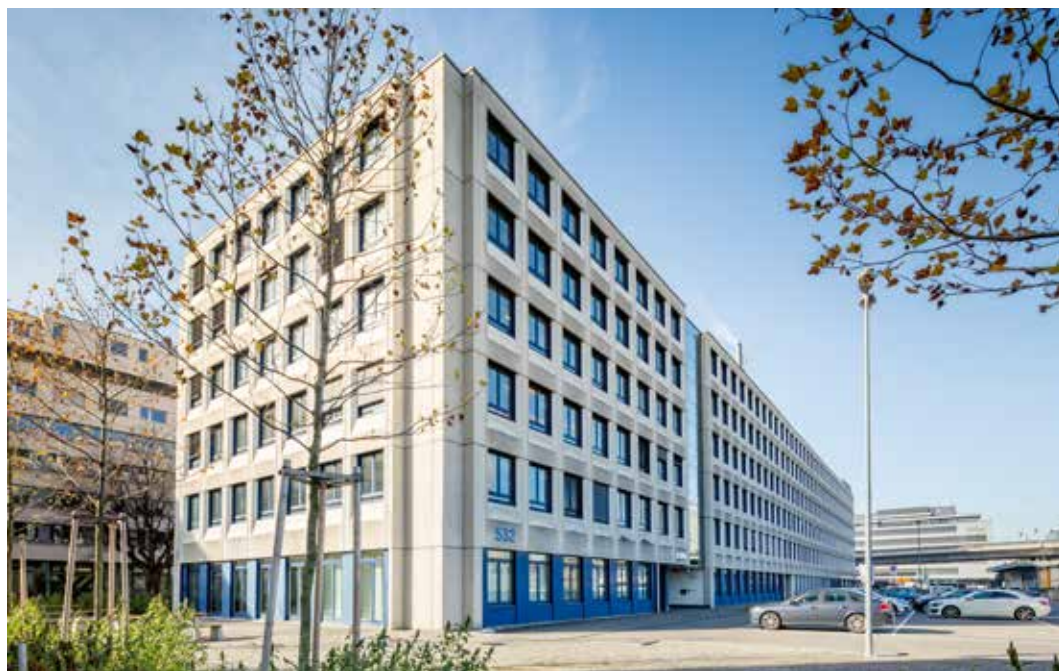
Neues Gesundheitscluster an der Hohlstrasse in Zürich.
