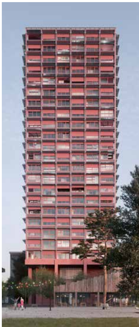
Das 24-stöckige Gebäude wurde in Holz-Hybrid-Bauweise erstellt. Es ist 75 m hoch. BILD: STUDIOBLOMEN
