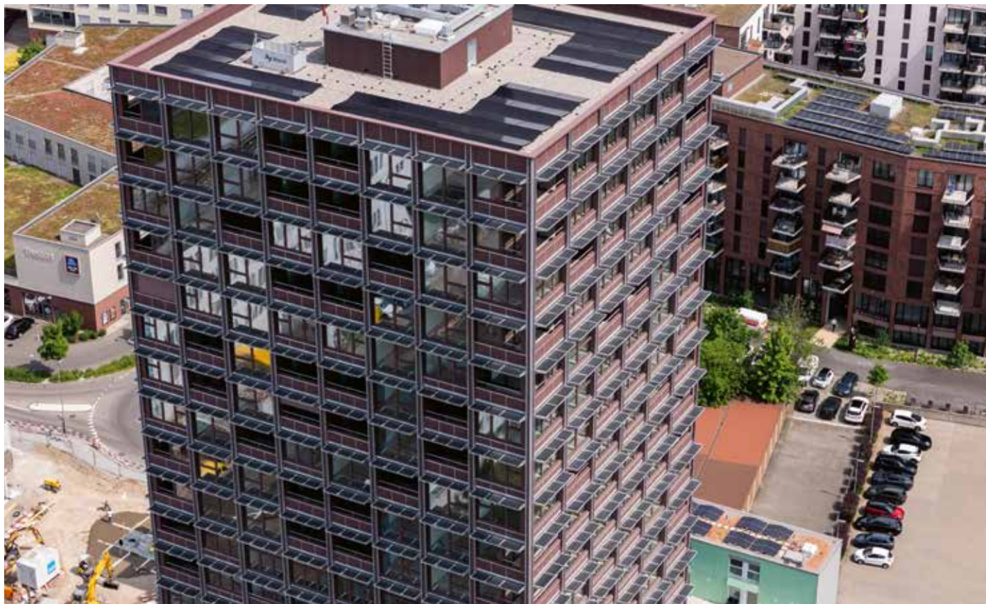
1764 Doppelglas-Solarmodule in vier unterschiedlichen Längen und einer Breite von 80 cm: Die PV-Anlage an Fassade und auf dem Dach deckt einen Teil des Strombedarfs ab. BILD: RUCH METALLBAU
