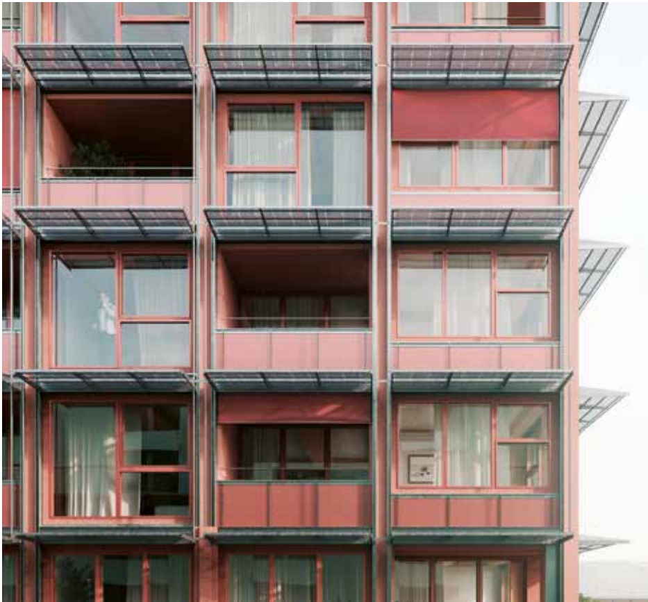
Die PV-Module wurden in Form von Brisesoleil und somit auch als Sonnenschutz für darunterliegende Fenster und Loggias angebracht. BILD: STUDIOBLOMEN
