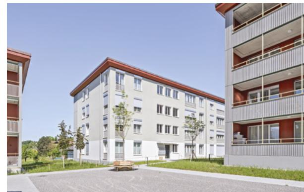
Die Überbauung wurde in Massivbauweise erstellt. Die vier Gebäude stehen auf einem Untergeschoß, während sich dazwischen eine Tiefgarage für 73 Abstellplätze erstreckt. Die Fassade besteht aus einer Kompaktfassade nach Minergie P-Standard mit einem robusten mineralischen Putz. Die Balkonschichten werden mit einer Holzschalung akzentuiert und erinnern an die Lauben der Umgebung.
