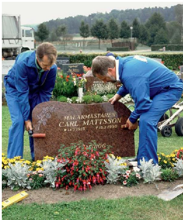
Gravvård monteras på synlig sockel efter grundläggning.
